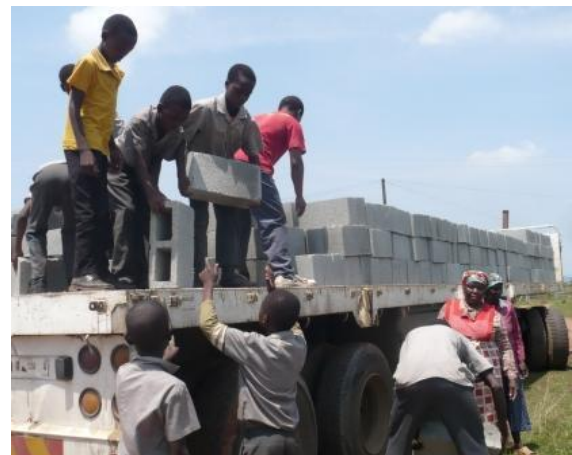
Die Steine für das Ausbildungszentrum werden abgeladen
