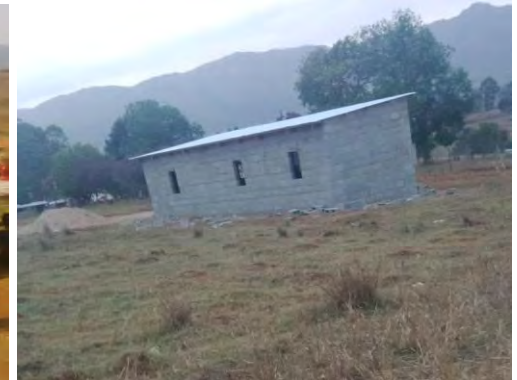
Neubau Küche im Regen
