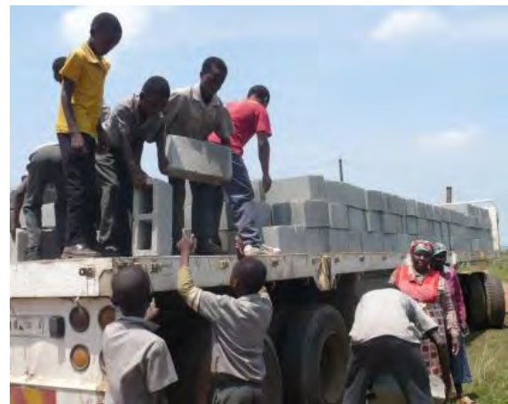
Die Steine für das Ausbildungszentrum werden abgeladen
